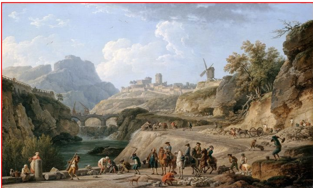
Vernet : construction d'un grand chemin.
