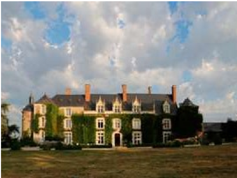
Les travaux du XVII e siècle nous laissent une façade à fenêtres à meneaux surmontées de lucarnes à pinacles et crochets.
